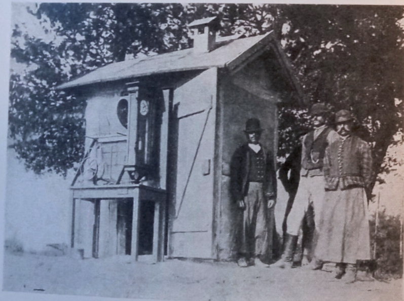
66. ábra. A kenesei limnografus végleges felállítása előtt, a szerkezet bemutatására. (Id. Lóczy Lajos felvétele.)
